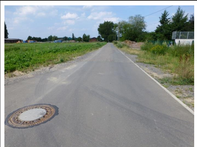
Abb. 3: Weg zum Klärwerk und weiterer „Hinterlieger“
