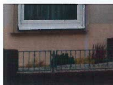
Mauer mit Metallelement
